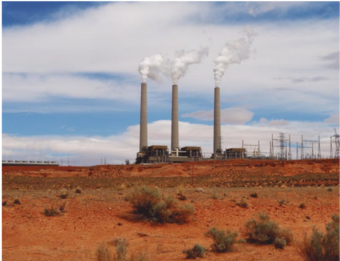
Centrale électrique dans la réserve Navajo de Page, Arizona, États-Unis (photo : Alex Proimos, bit.ly/35hAzRh).
