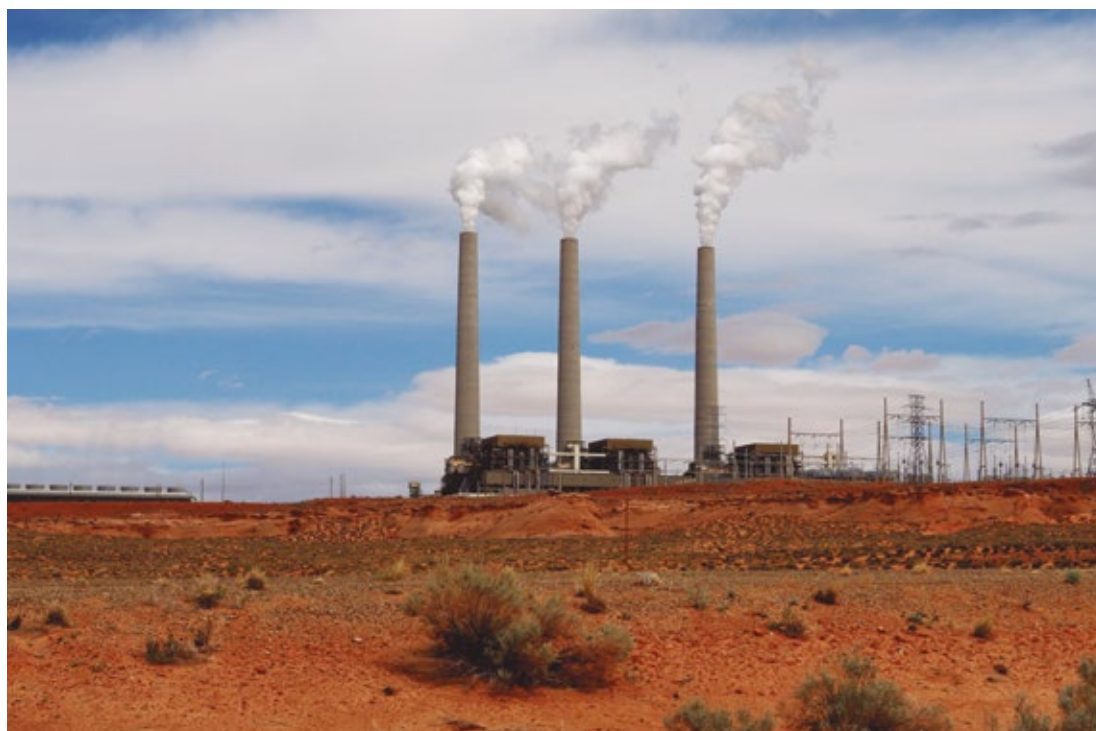
Planta de generación de energía en la Reserva Navajo de Page, Arizona, Estados Unidos (foto: Alex Proimos, bit.ly/35hAzRh).-
